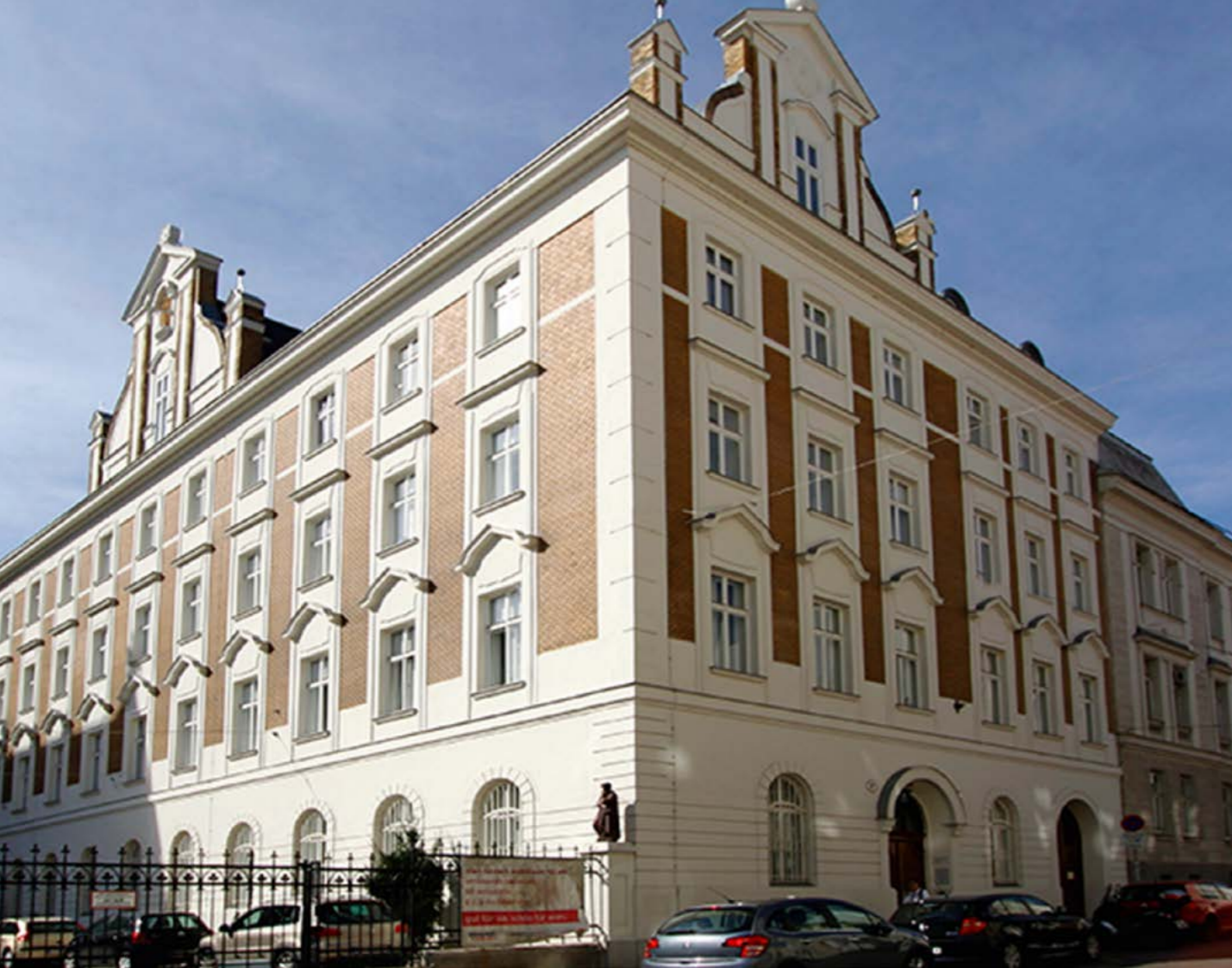
Denkmalgeschützte Sanierung in der Kaiserstraße, © Schöberl &amp; Pöll GmbH
